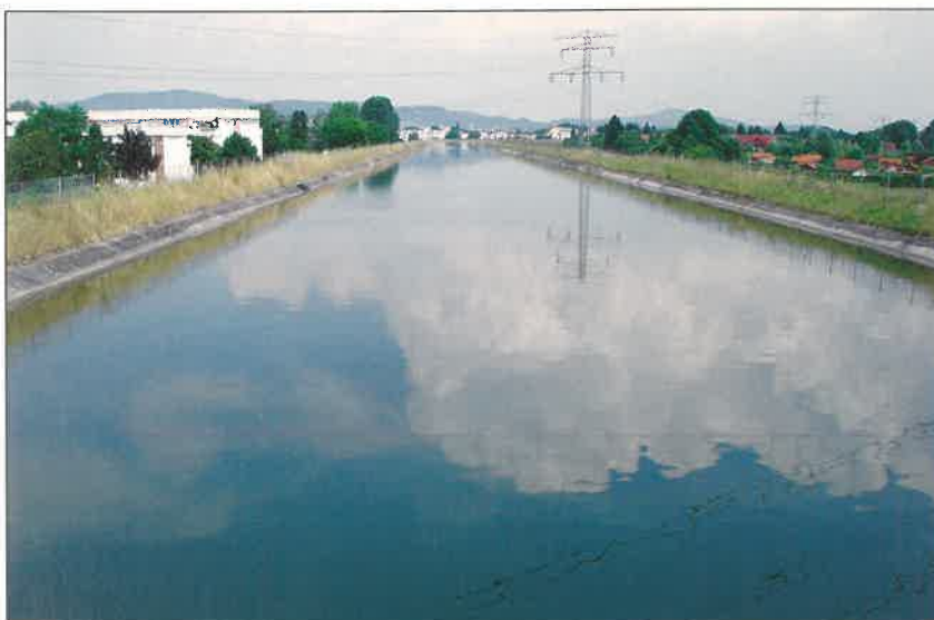
Abb. 19: Der Oberwasserkanal des Kraftwerks Kleinmünchen, auch genannt Jaukerbach, ist ein abschreckendes Beispiel des technokratischen Wasserbaustils der 1970er-Jahre: Eine aus der Landschaft herausgehobene, betonierte Wasserrinne, völlig struktur- und gesichtslos, die lediglich dazu dient, das Traunwasser der Turbine zuzuleiten. Foto: G. Laister
