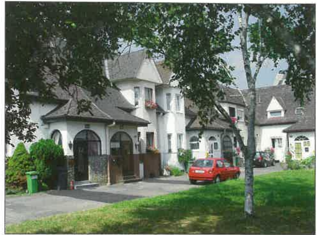
Abb. 9: Die so genannte Eisenbahnersiedlung, erbaut in den 1920er-Jahren, ist ein architektonisches Juwel, das sich mitten im Siedlungsgebiet verbirgt. Foto: G. Laister
