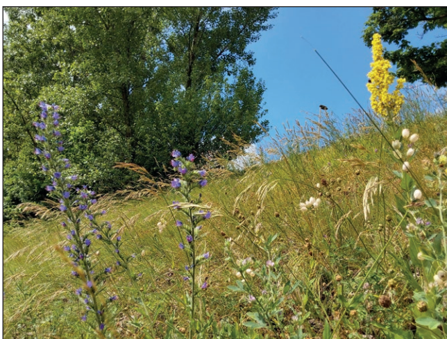
Abb. 13: Artenreiche, wärmegetönte Magerwiese auf einer Dammböschung, für die eine einmalige Herbstmahd vollkommen ausreicht.
